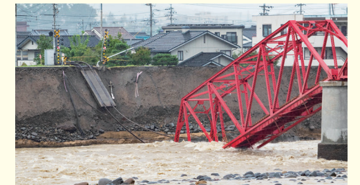
令和元年台風第19号での災害の様子
