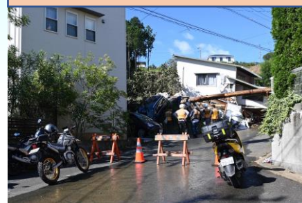
天竜区緑恵台土砂崩落
