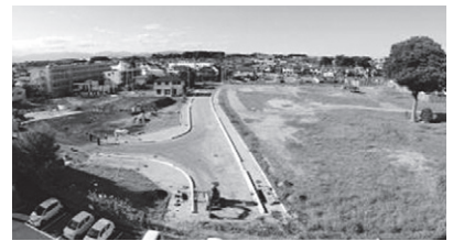
【入曽駅東口、区画道路と駅前広場の整備状況】 (2022年10月時点)
