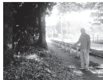
【不具合か所の現地確認】
