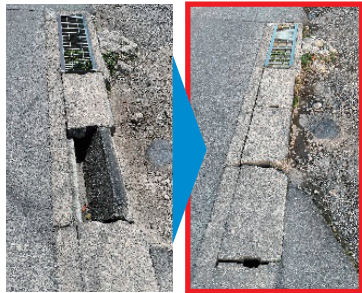
側溝のフタ破損修繕
