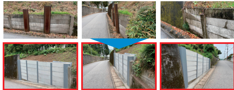
老朽化した土留めの修繕
