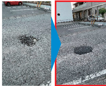
道路のアスファルト陥没修繕
